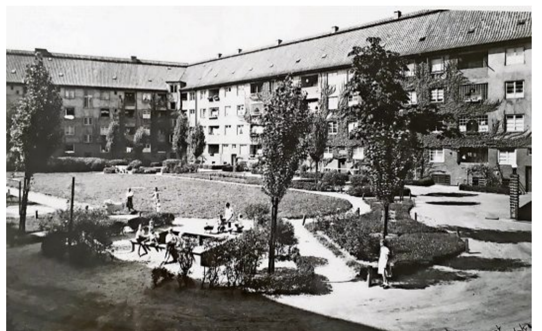
Gestaltete Innenhöfe – wie hier an der Johannesstraße – gab es schon in den 1930er Jahren.
